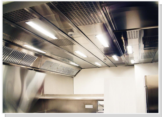
Techo filtrante de 30m 2 instalado en cocina del casino de Barcelona.
